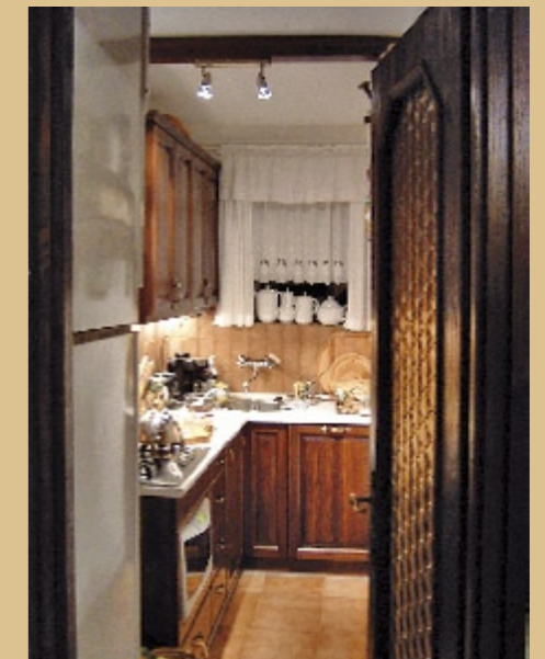
A tömörfa ajtók többrétegű lakkozást kaptak. A spotokat egy ál-mestergerendára szerelték
