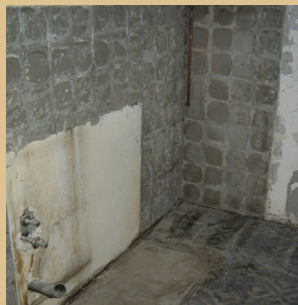
Kidobták az öreg bútort, leverték a csempét, felszedték az öreg PVC burkolatot
