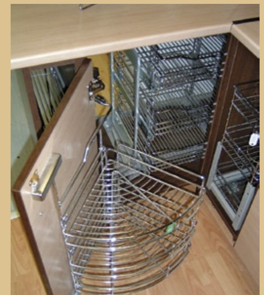
A szerkezet nem olcsó, de minden centit kihasznál. Az ajtó nyitása kitolja a sarokból a rácspolcokat
