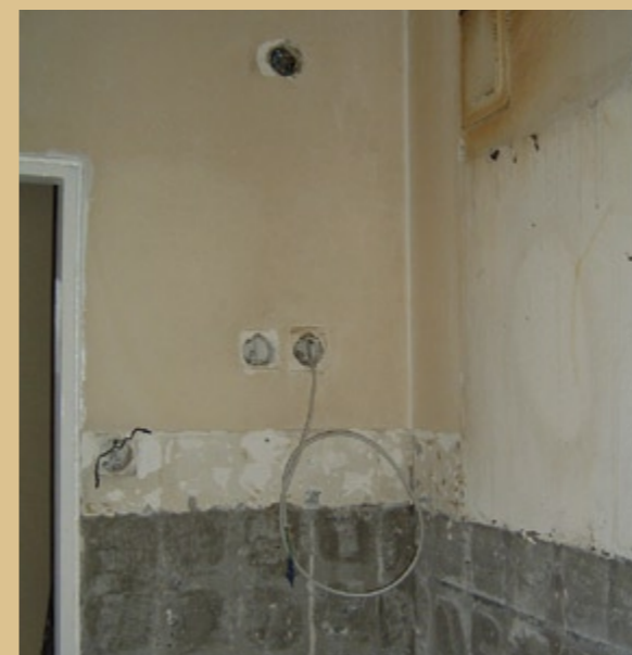
Az elektromos vezetékeket szerencsére bontás nélkül tudták cserélni, sikerült kihúzni a régi alumínium kábeleket
