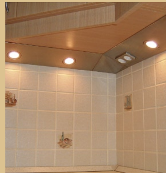
Praktikus a világítás: a felső szekrény alá szerelt lámpasorban konektorok is vannak és nem kellett falat sem bontani
